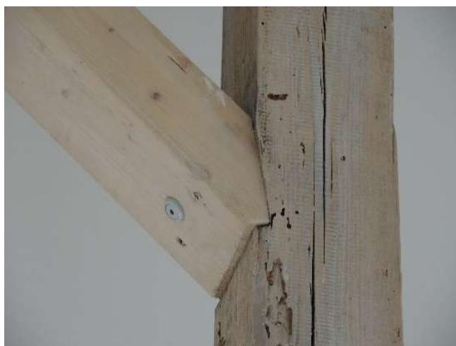
Abbildung 7 – Abgestirnte Zapfenverbindung mit Versatz
