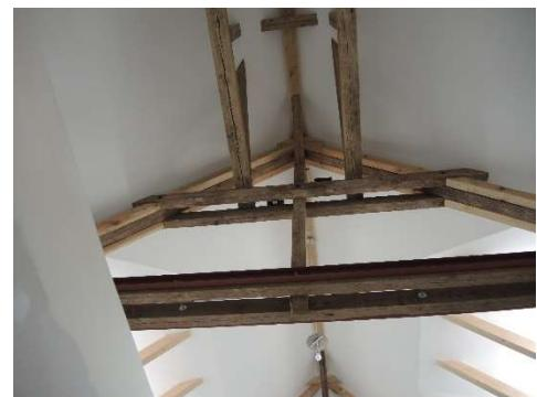
Abbildung 5 - Zangenkonstruktion an der Stelle des ehemaligen Turmes
