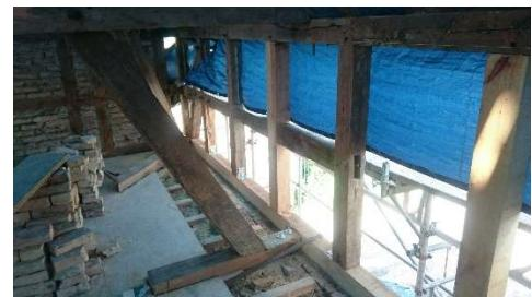
Abbildung 8 – Verbindung der Schwelle mit Flachstahl
